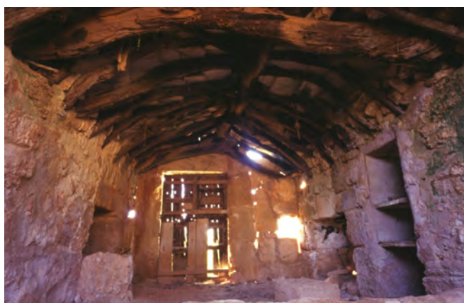
Combinació de pedra amb fusta
